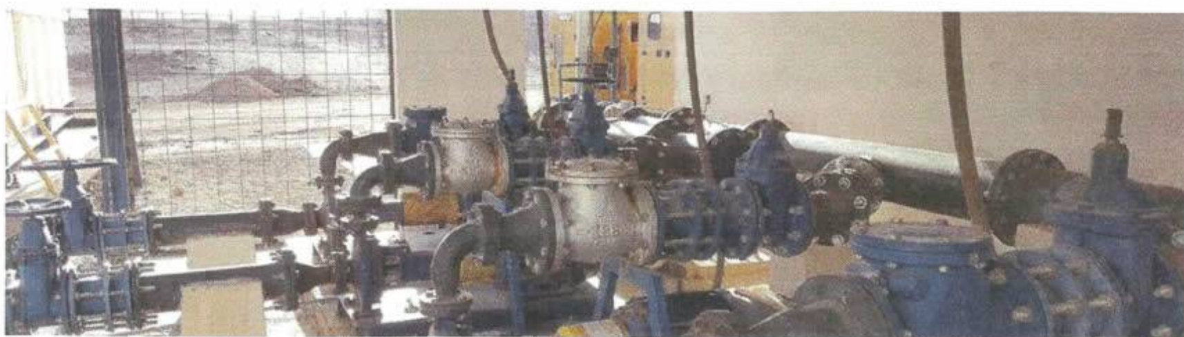
Figura 7: Bombas de impulsión de agua potable hacia estanque TK1000
