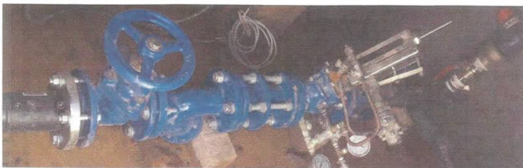
Figura 14: válvula reguladora de presión.
