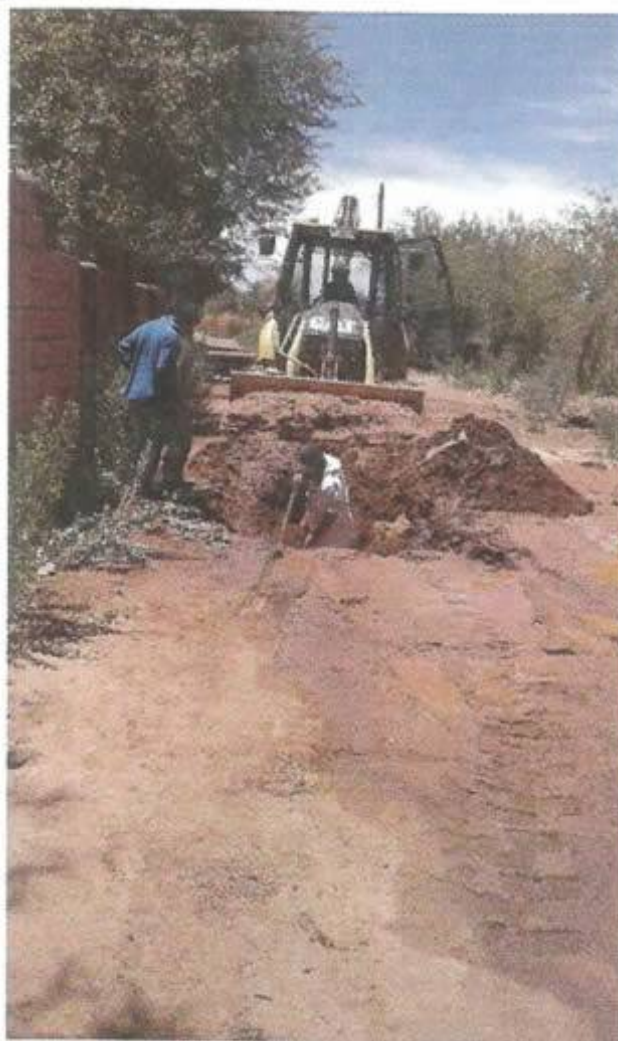
Figura 10: Reparación de filtración.
