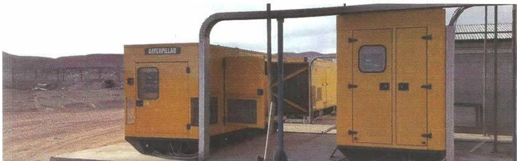
Figura 4: Motores de generación Planta de ósmosis.
